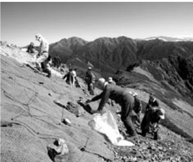
写真5：塩見岳山頂直下のヤシネットの敷設作業
