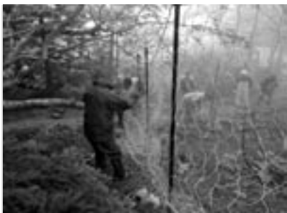
2009.7.9 雨の中柵設置
